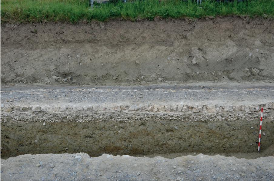
**Fig. 38.** Coupe stratigraphique longitudinale mettant en évidence les deux premiers états de construction de la voie. Les blocs empierrés au sommet constituent le deuxième état (US 19), recouvrant la chaussée du premier état.
